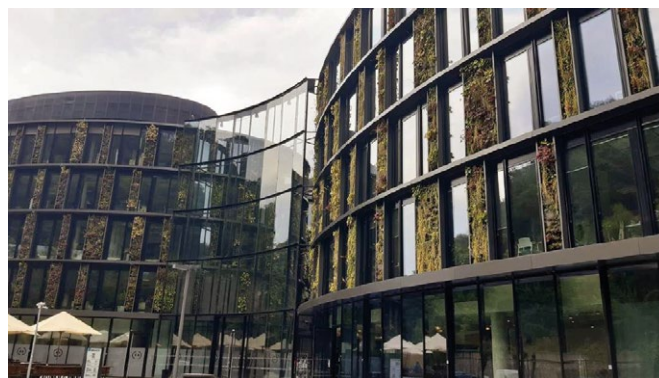
Obr. 8 Zelené fasády, příklad městské adaptace
